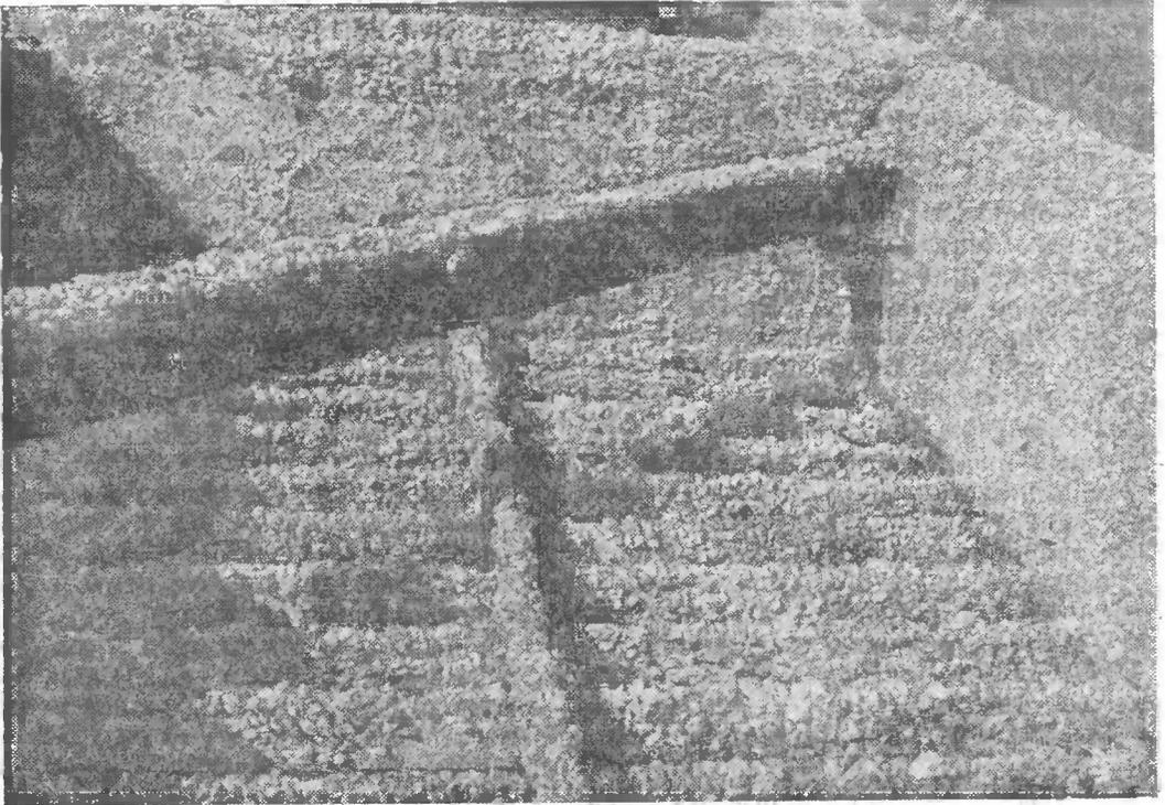
Фиг. 1. Решётки Днепрогэса, обросшие дрейссеной. Фото Днепрогэса.
